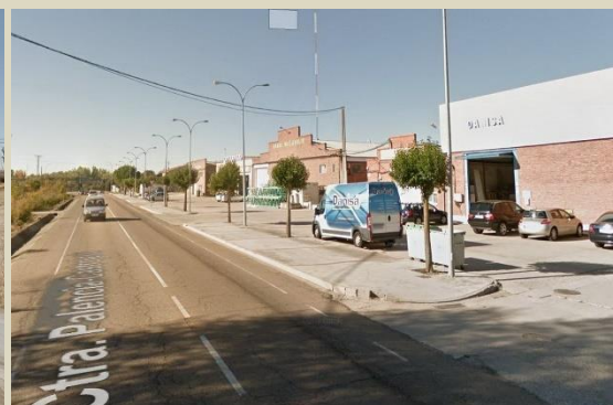
Tramo central – Polígono San Blas
