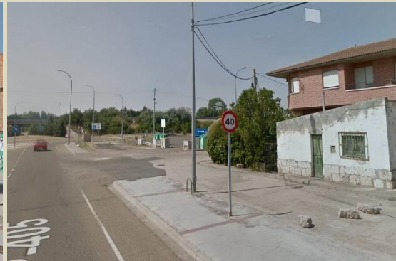
Tramo sur – Polígono San Blas
