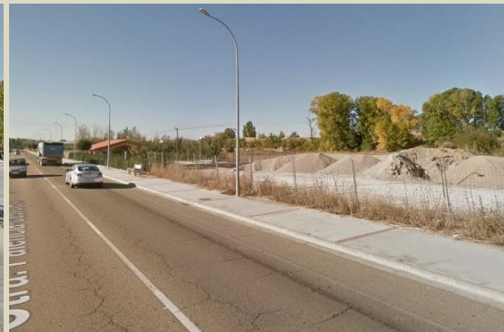
Tramo norte – instalación de áridos
