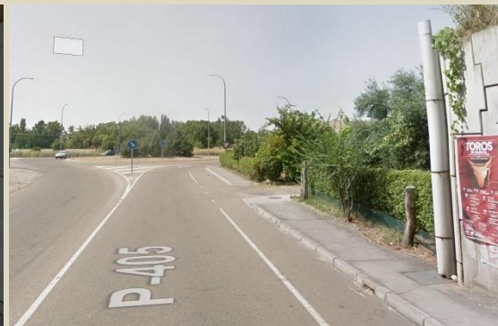
Tramo sur – salida del paso elevado
