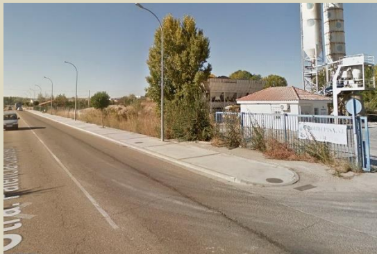
Tramo norte – instalación de áridos
