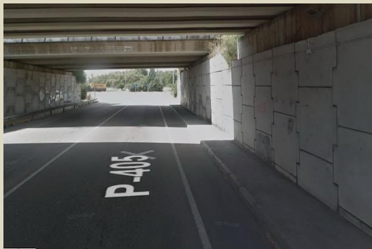
Tramo sur – paso elevado de la A-65
