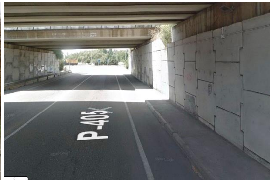
Paso elevado de la A-65
