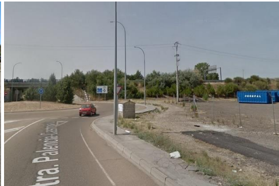
Entrada a glorieta y caseta de válvulas
