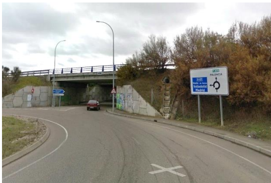
Salida glorieta y talud de la A-65
