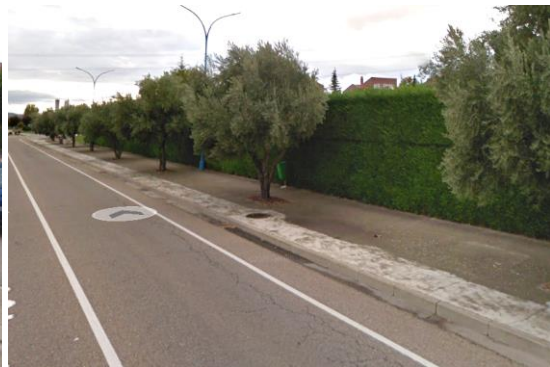
Vía sobre acera existente
